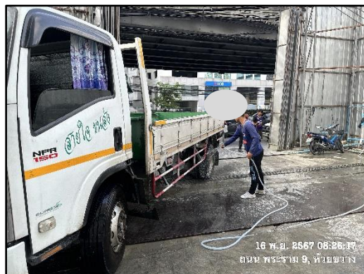
รูปที่ 13 พื้นที่สำหรับล้างล้อรถและคนงานล้างล้อรถบรรทุก
